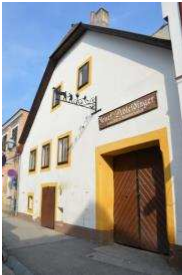
Abbildung 50: Zwettl - Ableidinger Schmiede, Straßenansicht Istzustand
