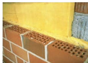
Sicherstellung der Winddichtheit durch korrekte Schichtenfolge
