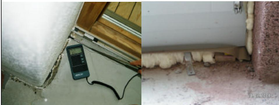
**Leckage Anschluss Terrassentür / Rohbeton undicht**
