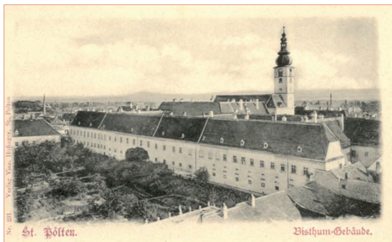
Abb. 37: St. Pölten, Bistumsgebäude, ca. 1900
