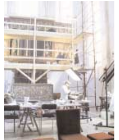
Pfarrkirche Schönbach, Chorraum mit Eingerüstung des Hochaltäres und Restaurierwerkstatt des Bundesdenkmalamtes im Sommer 2001
