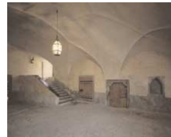
Erhaltene rustikale Steinplasterung und Holztüren aus dem 17. Jh.
